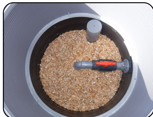
嵩上げ状況確認
