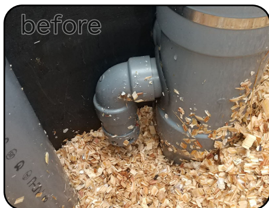
オーバーフロー管露出状況 異物混入防止ネット取付前
