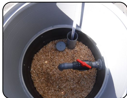
検水管内水位確認状況
