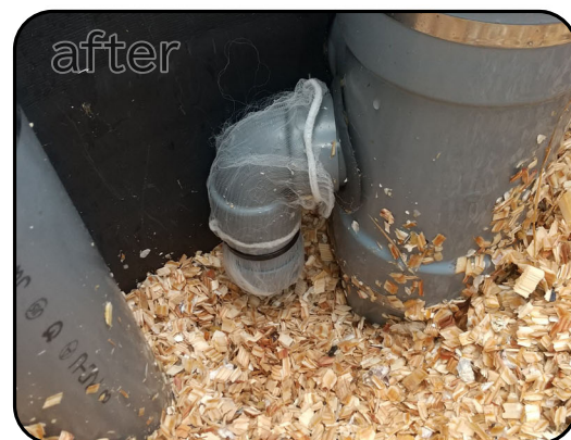
オーバーフロー管露出状況 異物混入防止ネット取付後
