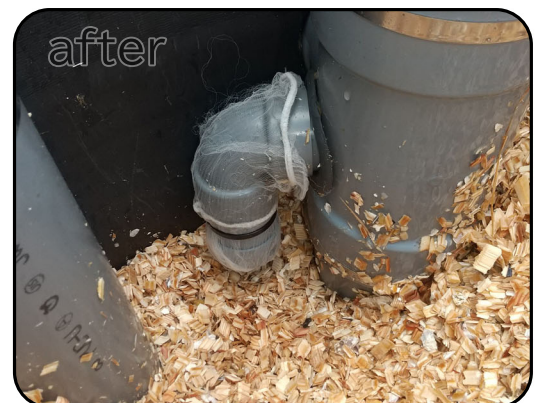
オーバーフロー管露出状況 異物混入防止ネット取付後
