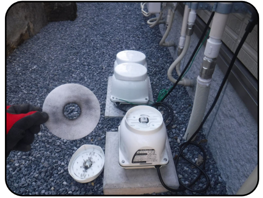
ブロア点検 エアフィルター清掃状況
