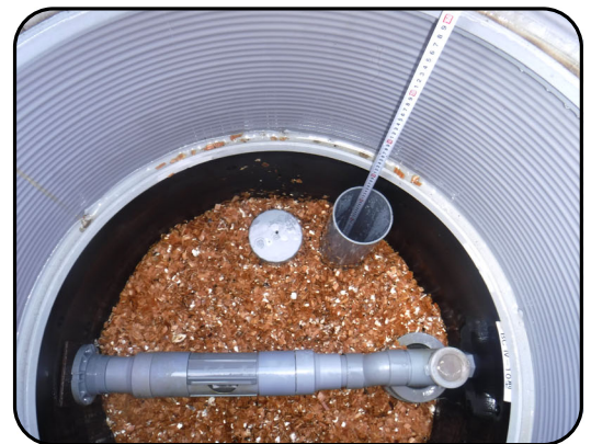
検水管内水位確認状況
