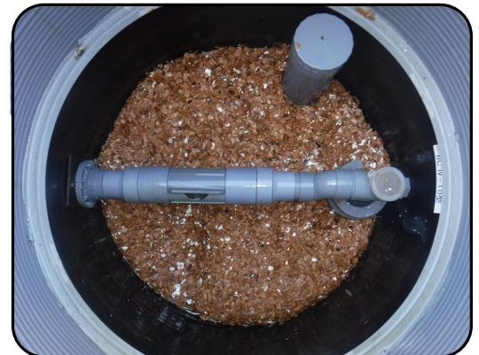
嵩上げ状況確認
