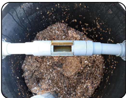
回転ゲート調整 全閉状態
